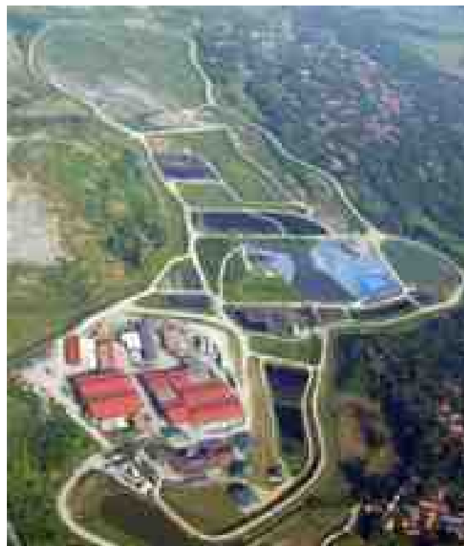
インドネシアの有害廃棄物最終処理施設 (出典: DOWAエコシステム株式会社)
