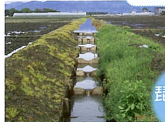
代かき前から堰板を設置
