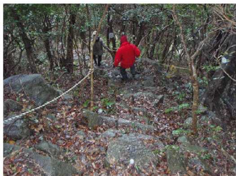
⑥傾斜が急な上、土砂や枝葉が階段に堆積し、また踏面が傾いているところもあり、滑りやすくなっている。
