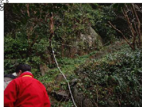
⑧階段が整備されているが、土砂や枝葉が階段に堆積し、滑りやすくなっている。補助ロープが設置されているが使いにくい。
