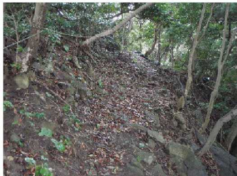
③歩道に土砂が堆積し、十分な歩行幅員が確保されていない。
