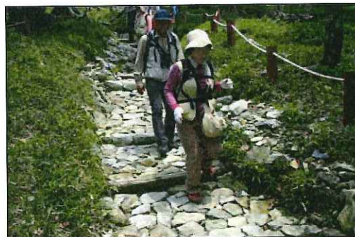
写真3-3-7 空石積み工法による歩道整備
