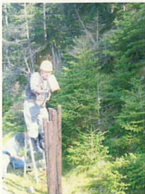
小規模木柱柵の設置
