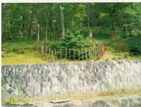
ドライブウェイ沿いに設置した木柱柵
