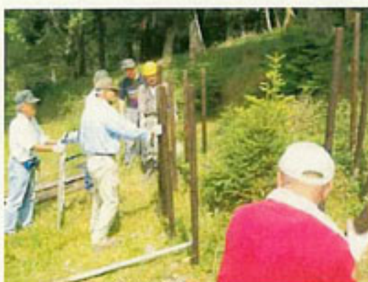
小規模木柱柵の設置
