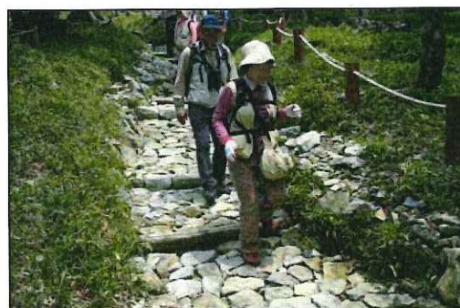
写真3-3-7 空石積み工法による歩道整備
