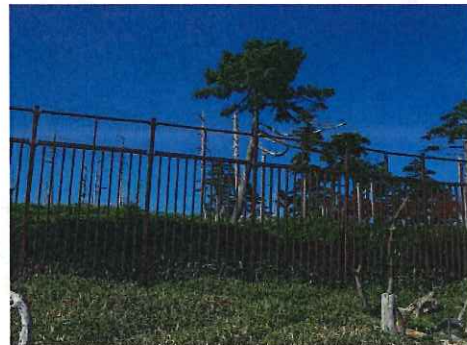
写真3-1-2 防鹿柵 (耐雪用格子柵)
