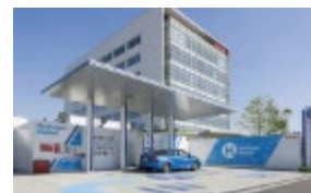
中規模 水素ステーション
