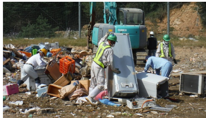
玖谷埋立地内の分別展開場所での作業
