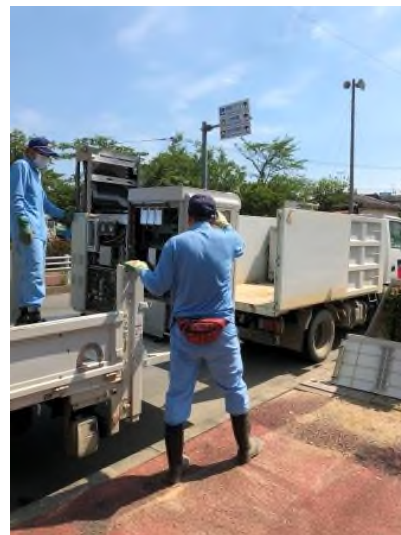
パワーゲート付きトラックを活用したダンプ車への積込作業
