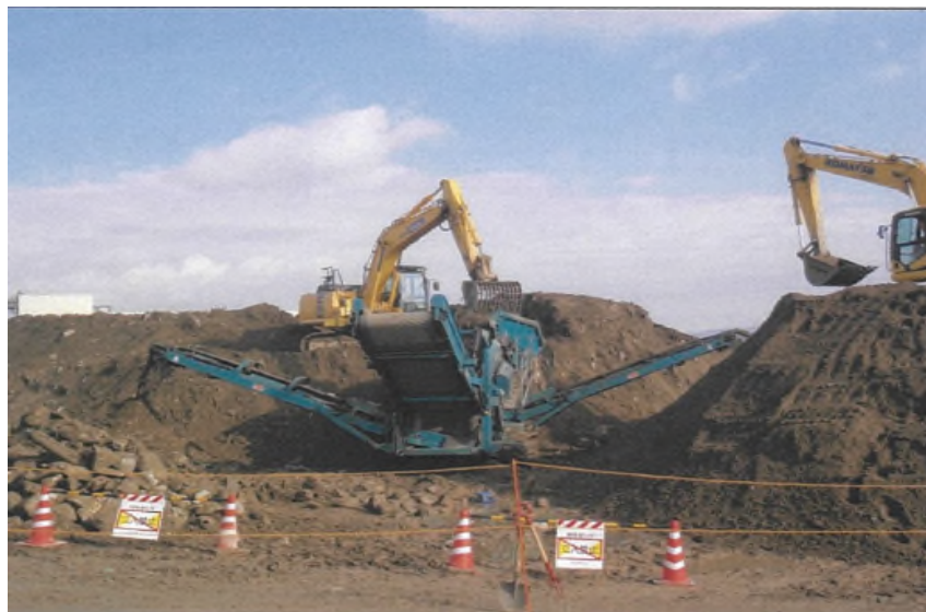
2次仮置場の振動式選別機での選別
