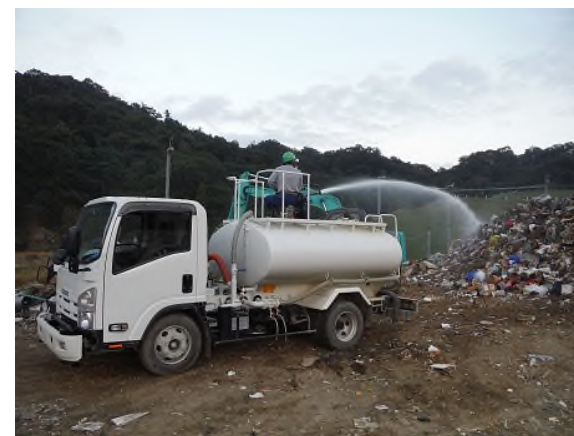
散水車両を活用し洗浄
