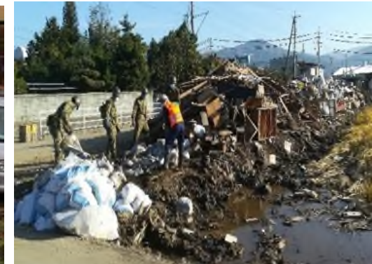
自衛隊による撤去作業
