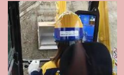
ICT施工(3次元データを重機に読み込み確認しながら施工)
