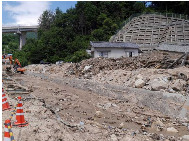
土砂により埋まった河川
