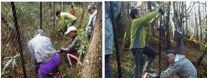
防鹿柵の補修の様子
