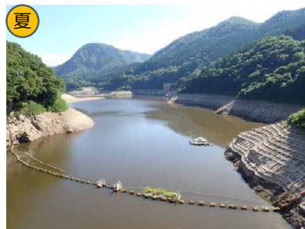
鳴子ダム底水放流状況（7/29撮影）
