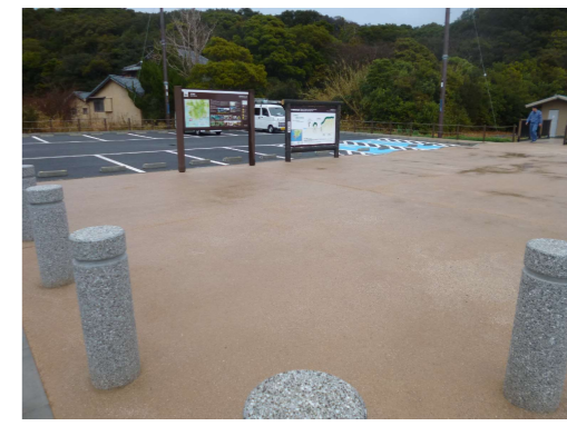
四阿設置場所(現況状況写真)
