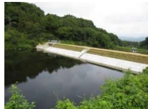
老朽化したため池の全面改修
