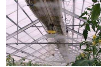
細霧冷房装置の設置
