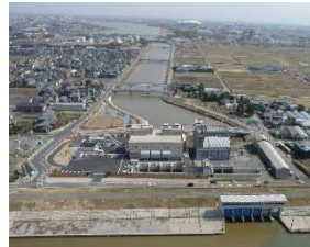
排水機場の整備
