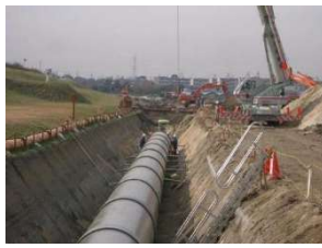
水路のパイプライン化
