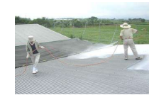
消石灰等の塗布
