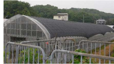
遮光ネットの設置
