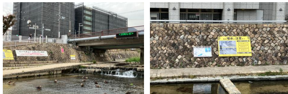
フィールドワーク：都賀川周辺の見学（電光掲示板、急な増水注意の警告看板等）
