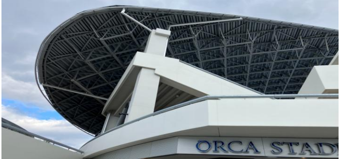
雨樋（オルカスタジアム屋根）
