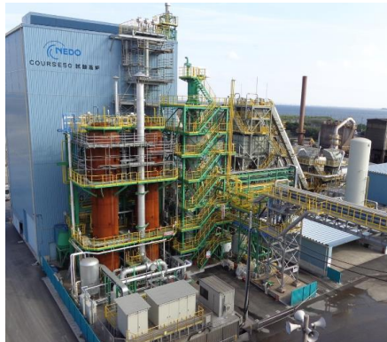
12m 3 小規模試験高炉(水素還元)
