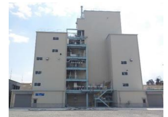
実証試験設備の外観
