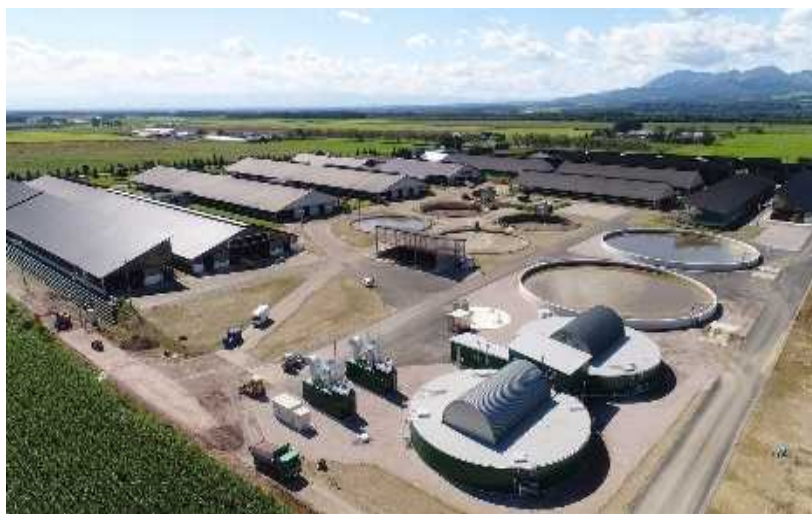
バイオガスプラント
