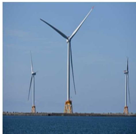
石狩湾新港洋上風力発電所
