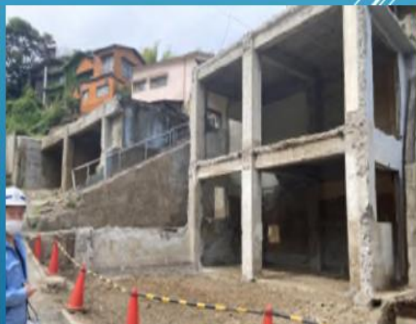
⑥ 梁や支柱を残して解体完了
