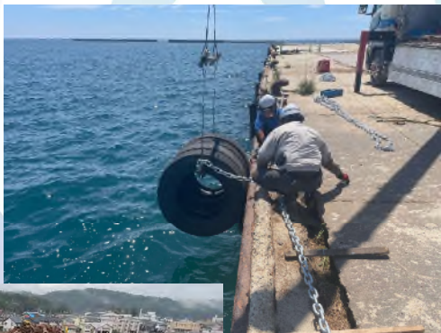
▲タイヤフェンダーの設置
