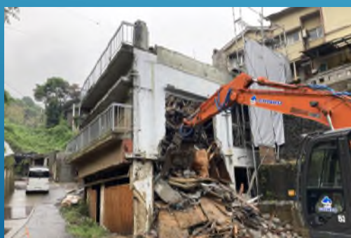
⑤ 下段側から解体
