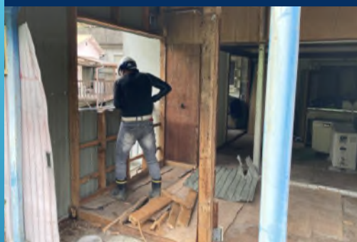
② 内装解体
