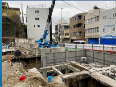
クレーンによるガレキ吊り上げ
