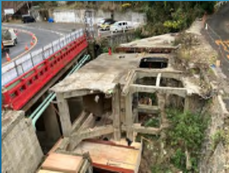
河川にせり出した基礎部(直下が逢初川)
