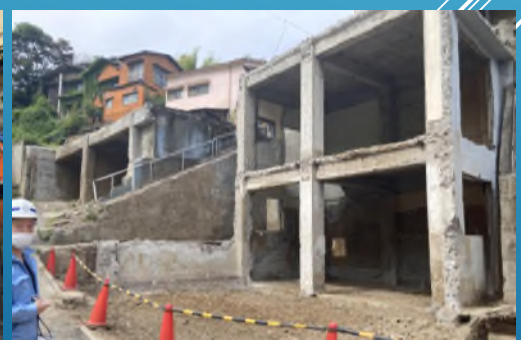
⑥ 梁や支柱を残して解体完了
