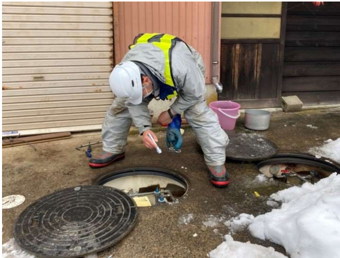
浄化槽の点検作業
