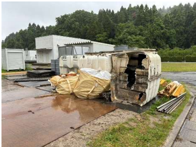
破損した浄化槽を洗浄
