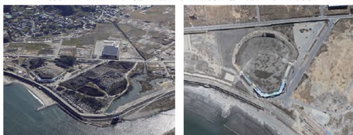
写真 3.5.7 宮古運動公園ヤード (左：平成 23 年 11 月撮影、右：平成 26 年 4 月撮影)
