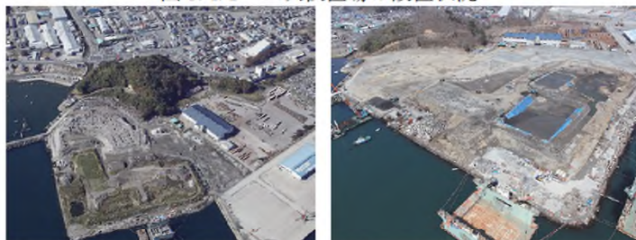
写真 3.5.6 藤原ヤード (左：平成 23 年 11 月撮影、右：平成 26 年 4 月撮影)
