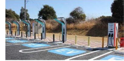
EV充電施設の設置を促進
