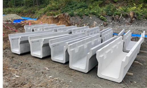
グリーンイノベーション基金を活用した低炭素型コンクリート試行事例(秋田県東成瀬村)
