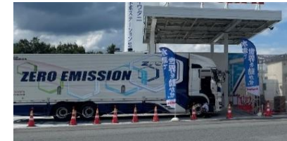
足柄SA(下り)に設置された水素ステーション
