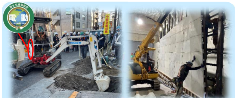
GX建設建機による施工
