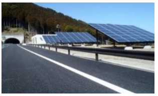
道路における太陽光発電の活用
