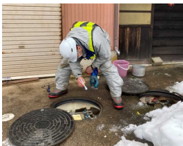
浄化槽の点検作業
