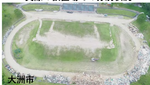
実際の仮置場での分別状況
