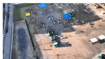
④仮置場からの搬出
