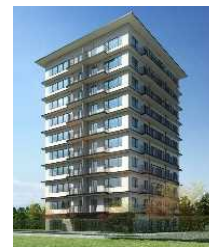
CLTを用いた10階建て 共同住宅
