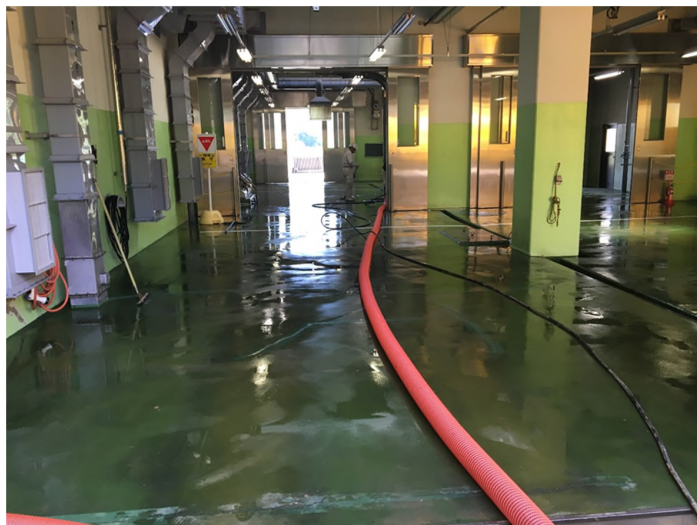
受入室床洗浄（近景）【平成30年7月13日(金) 15時13分 撮影】
