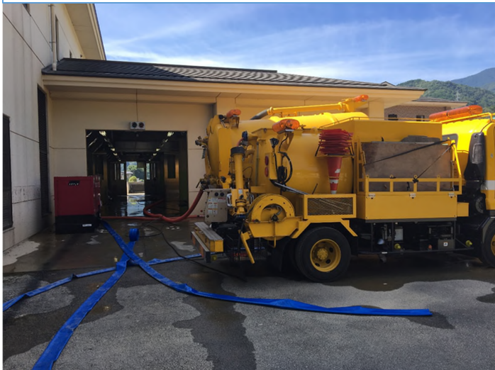
受入室床洗浄（遠景）【平成30年7月13日(金) 15時13分 撮影】
