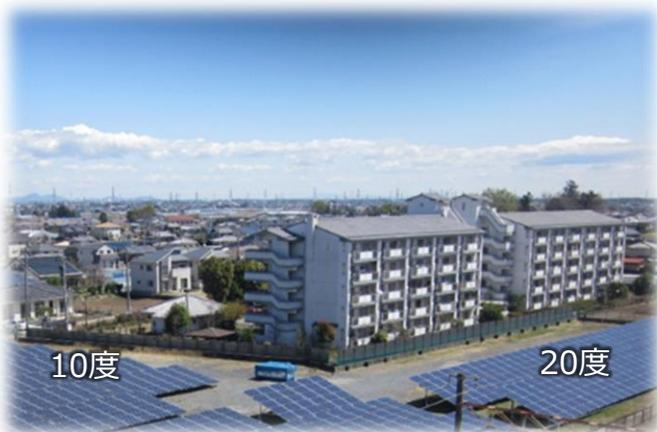
太陽光発電パネルからの近隣住宅等への反射光を低減するよう、発電所の設計段階で考慮
