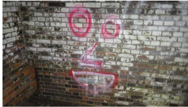
②砲台跡（隧道）（壕入口右壁）
