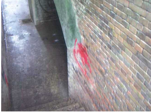
①砲台跡（隧道）（階段を降りて右壁）
