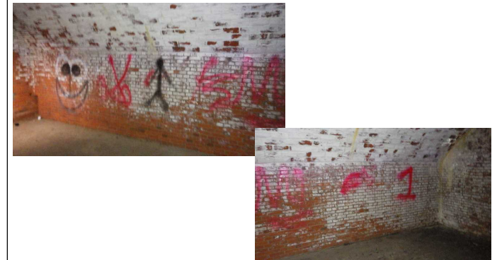
⑥砲台跡（隧道）（壕内左壁）
