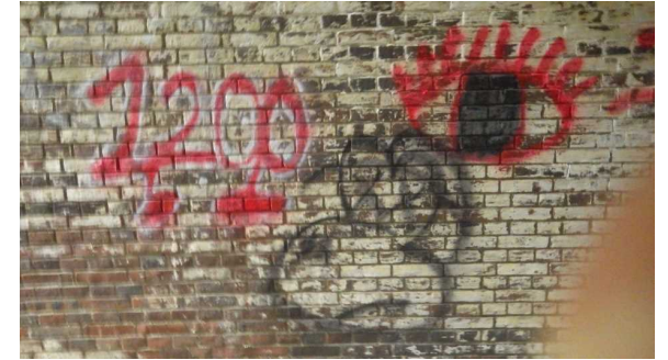
③砲台跡（隧道）（階段を降りて左壁）
