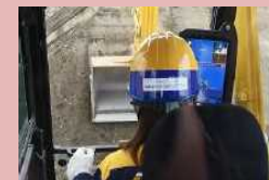
ICT施工(3次元データを重機に読み込み確認しながら施工)
