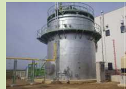
下水道施設におけるバイオメタン発酵事業
