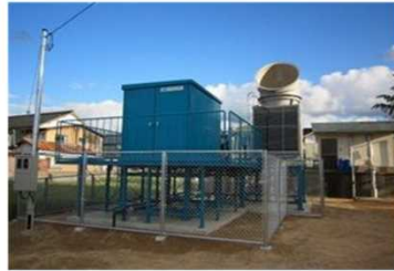
湯梨浜地熱発電所(20kW)
