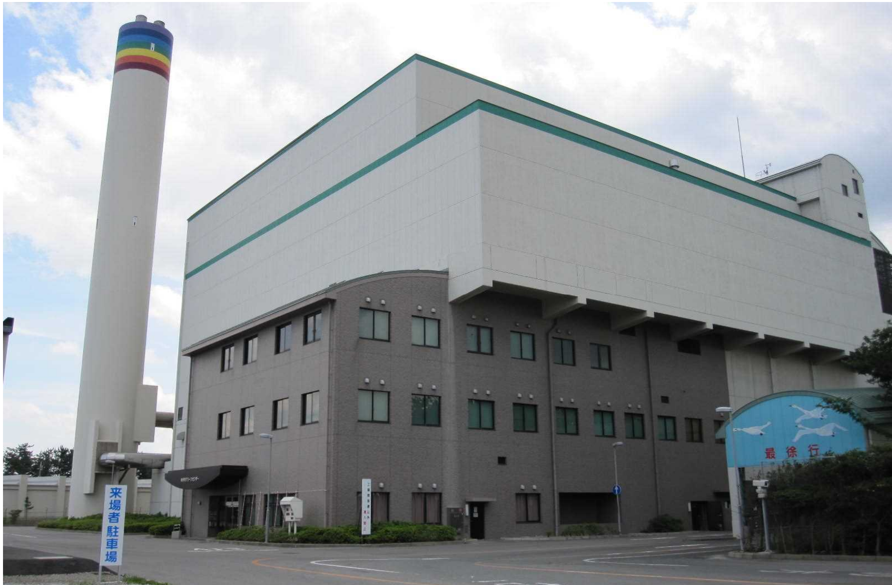
(米子市クリーンセンター)
