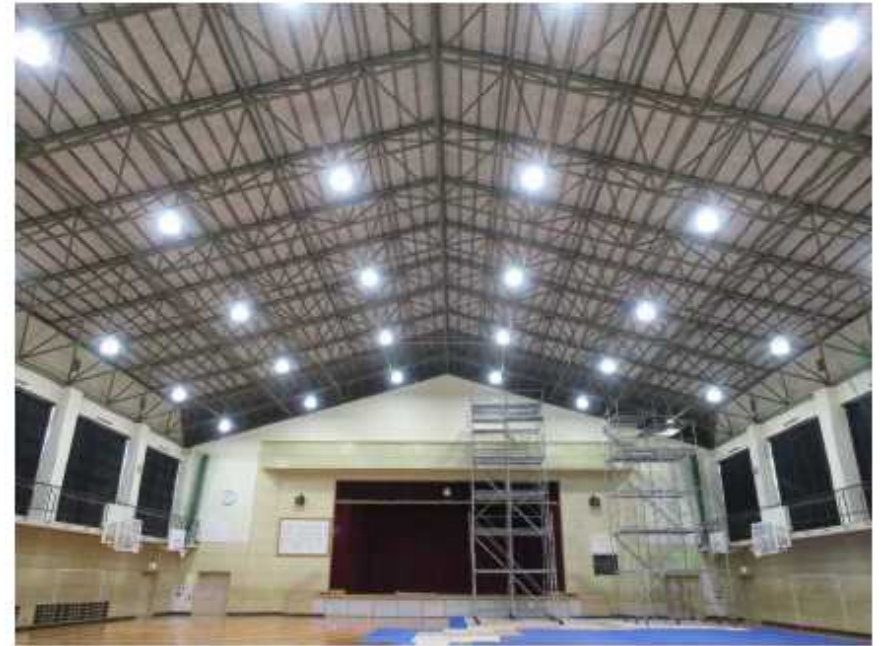
中学校体育館へのLED照明導入
