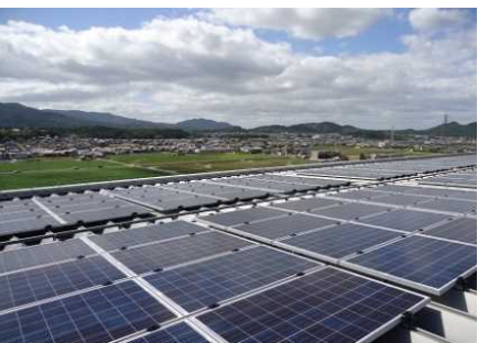
弐号機(105.6kw) 甲陸市民共同発電所
