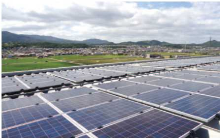
コナン市民共同発電所 式号機 甲陸発電所
