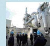
バイオマス発電所
