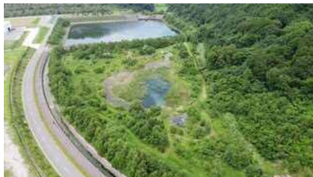
多奈川ビオトープの全景
