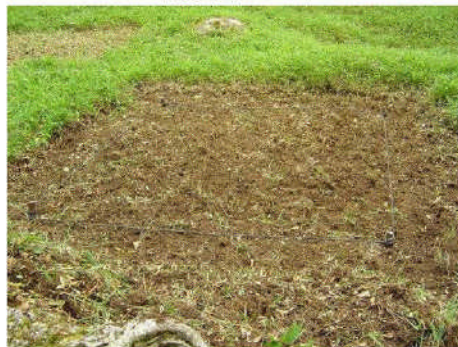
写真 2-1-5 表層土対策 （地掻き）
