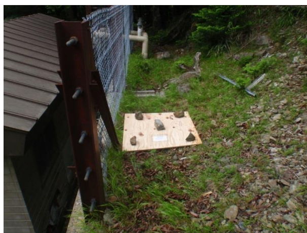
写真VI-4 ポンプ小屋 (H29. 7. 20)
