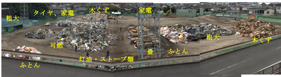
図 仮置場の分別例
