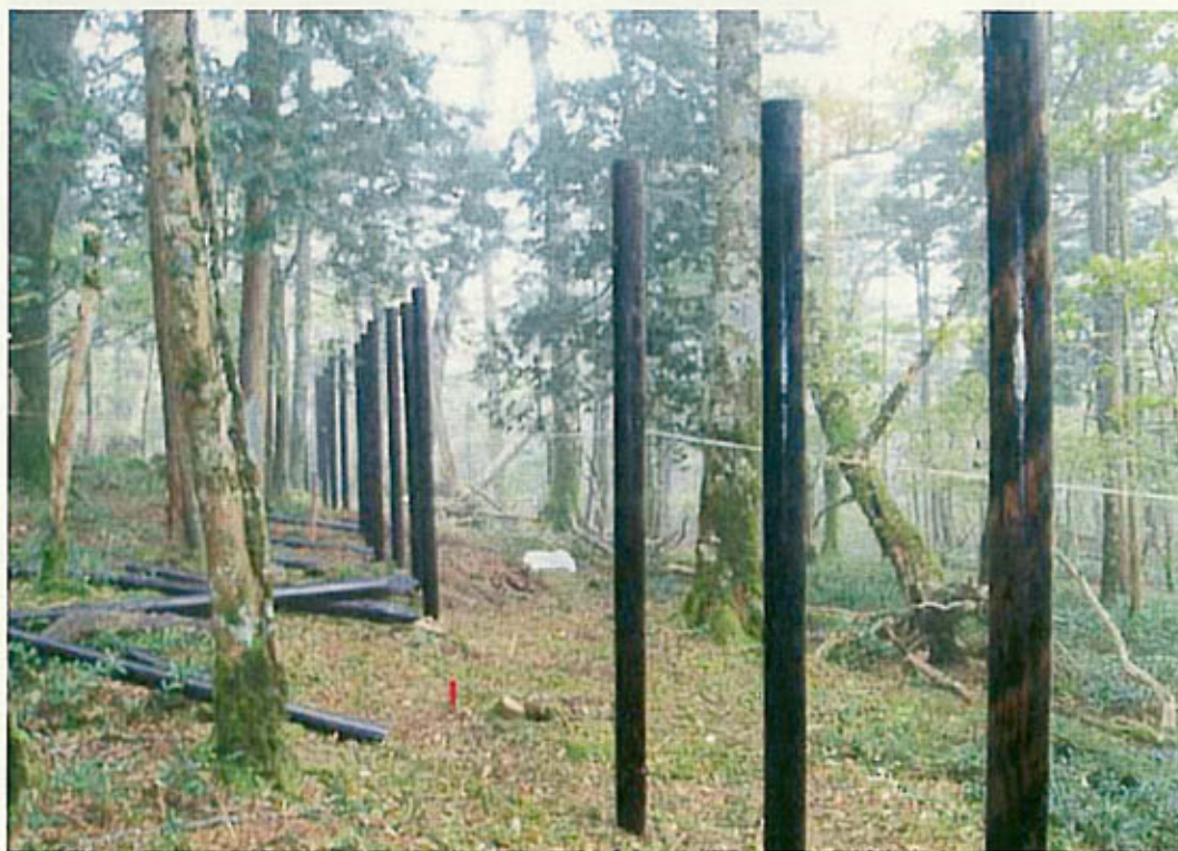
木柱防鹿柵（施工中）
