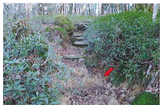
写真2：S-4の状況（平成24年11月25日撮影）
