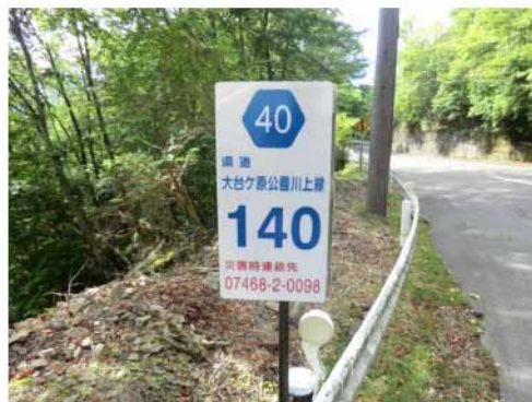
写真 1：新設された距離標（キロポスト）
