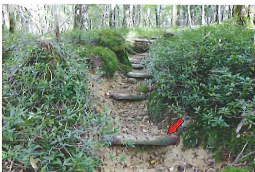
写真1：S-4の状況（平成23年9月15日撮影）
