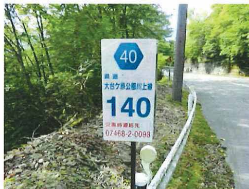
写真 1：新設された距離標（キロポスト）
