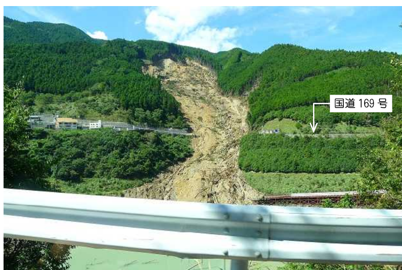
写真 1：国道 169 号(川上村迫地内)の被害状況(平成 23 年 9 月 13 日撮影)
