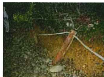
ロープ杭の抜け（KF-6）
