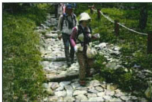
写真3-3-7 空石積み工法による歩道整備
