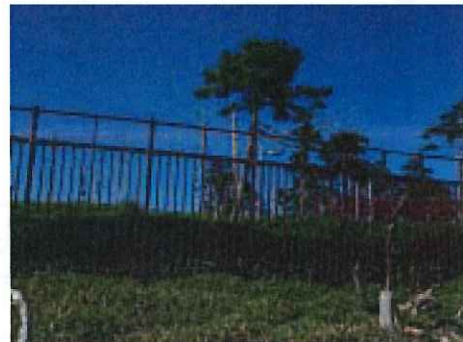
写真3-1-2 防鹿柵 (耐雪用格子柵)
