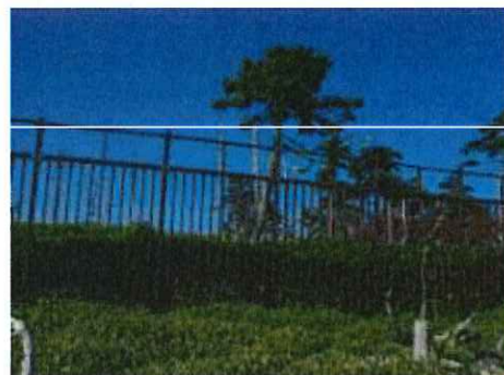
写真2 防鹿柵 (耐雪用格子柵)
