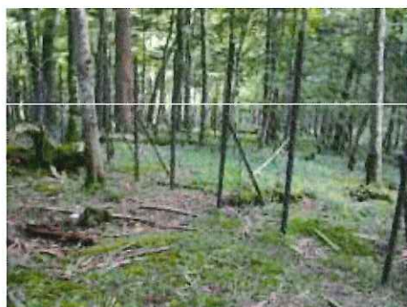
写真1 防鹿柵 (FRP柱+ステンレス入りネット)
