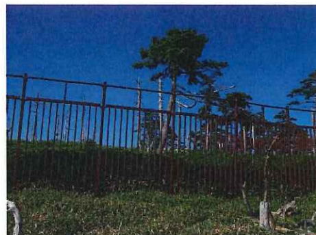
写真2 防鹿柵（耐雪用格子柵）
