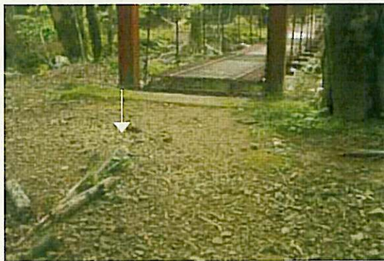
ヤマト谷吊橋
